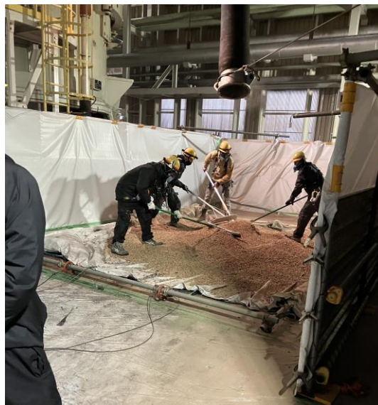
押し広げて目視点検
