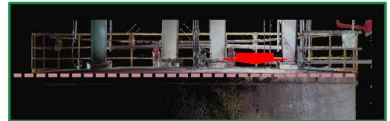
〈木質バイオマス用バンカ (側面)〉
