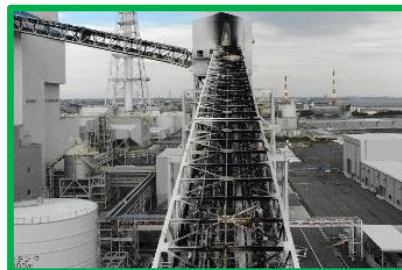
④: 延焼による 損傷
