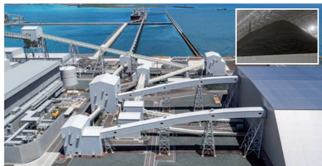
(中央)密閉式ベルトコンベヤ(右)屋内式貯炭場
